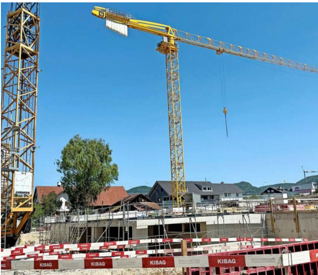
Die Tiefgarage steht schon. Auf ihr werden im August die Holzelemente platziert.
