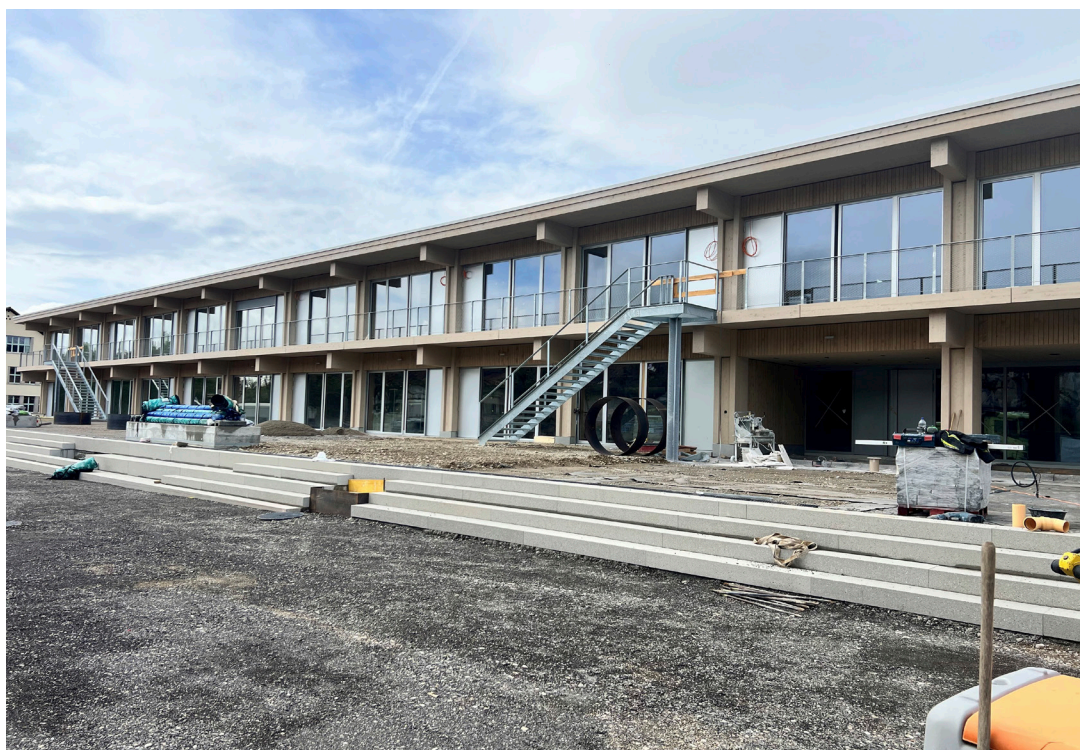
Die Bauarbeiten in und um das Schulhaus in Neunkirch sind auf der Zielgeraden.
